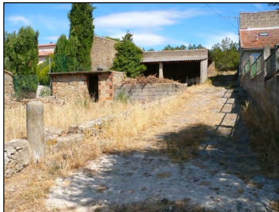
TERRAIN DANS LE LOTISSEMENT OUEST
