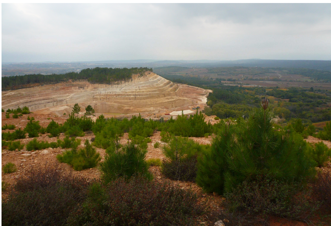
La carrière 2010 – vue de dessus
