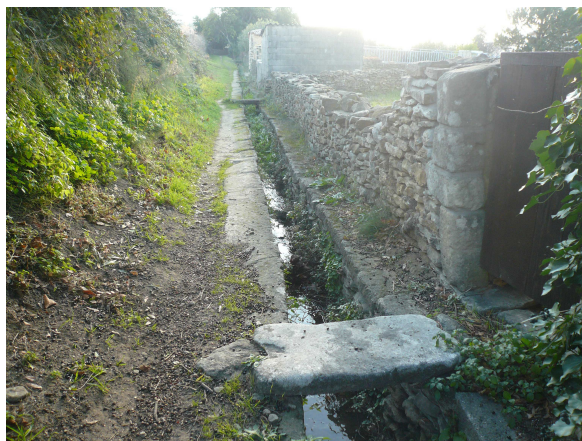
(canalette sur le chemin entre les jardins, pierres appareillées - photo 2012)
