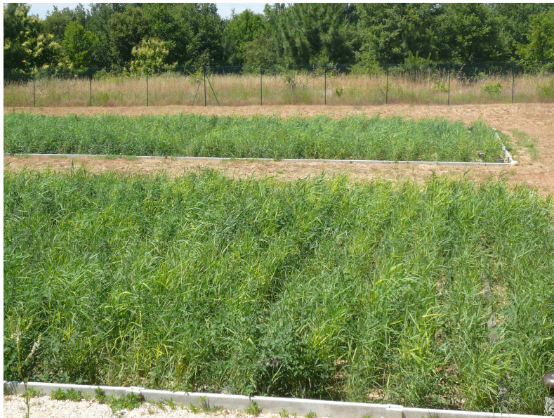
Les roseaux sont opérationnels - 2013-2014
