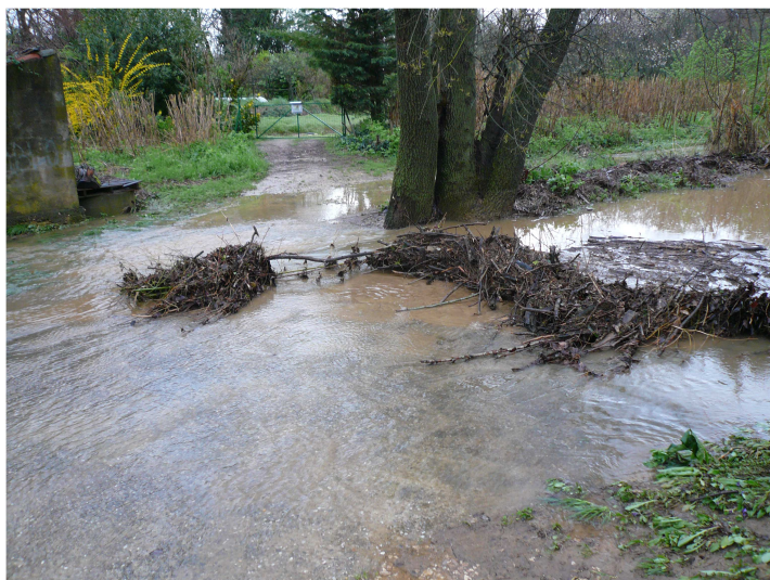
Crue de l'Alzon 2010 - pont du Plan- photo 2010
