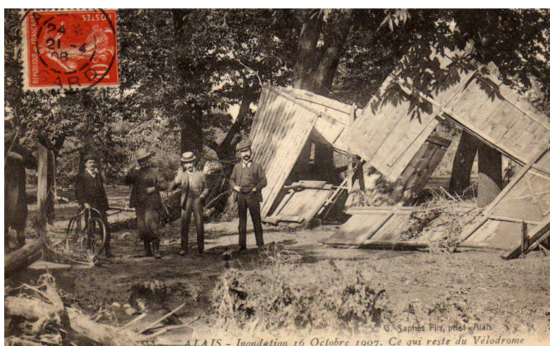
ALAIS - Inondation 16 Octobre 1907. Ce qui reste du Vélodrome inondation d'octobre 1907 - restes du vélodrome d'Alès - collection privée
