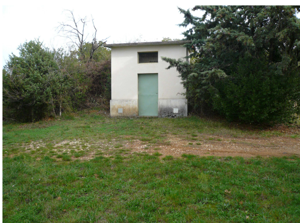
Réservoir de la Lauze -
