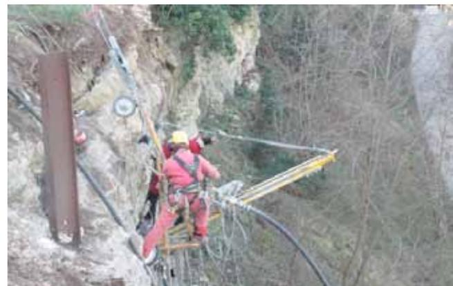
Au cours du chantier, une fissure inquiétante a été découverte suite à la dévégétalisation et les travaux acrobatiques ont permis de mettre en place des tirants pour conforter ce pan de falaise.
