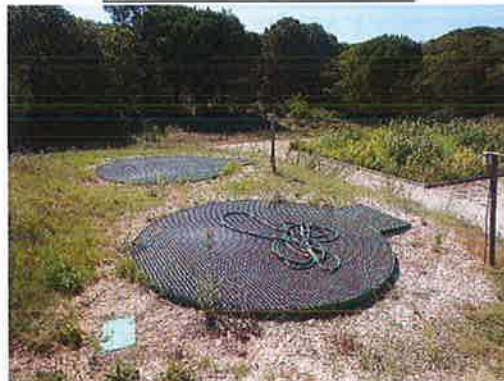
Entrée de la station d'épuration
