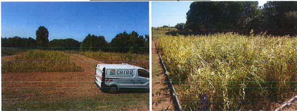
Filtres plantés de roseaux du 1 ère étage et du 2 ème étage
